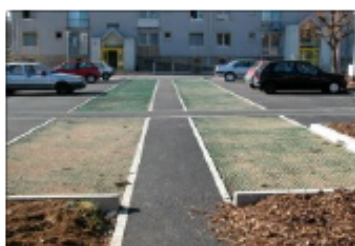
Exemple de parking réservoir à Albi
