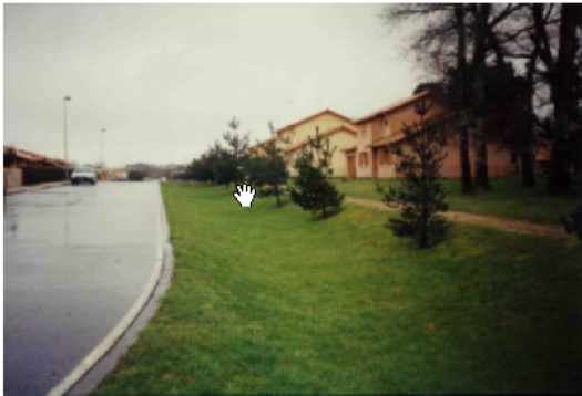
Noûe le long d'une voirie desservant un habitat aéré Source CETE du Sud-Ouest
